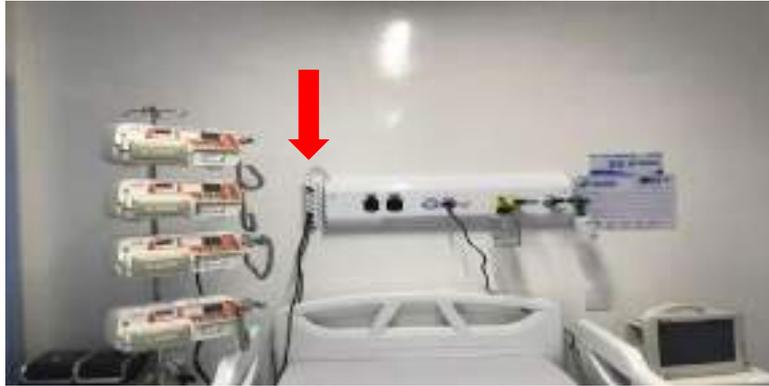
8. Pontos e oxigênio e ar comprimido instalado em altura, distância e quantidade inadequada, dificultando a instalação de equipamentos e acessórios de uso no paciente. Leitos muito próximo um do outro, o que dificulta o atendimento do paciente no leito e instalação de equipamentos pois não se tem espaço apropriado e seguro.
