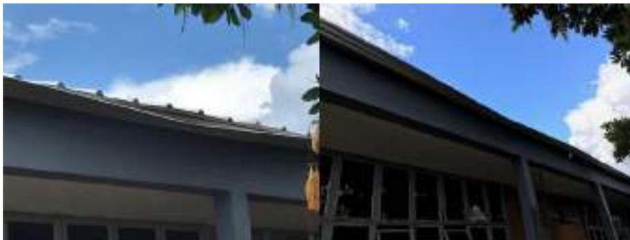
**Telhado com infiltração em vários setores, gesso caiu e mofando**
