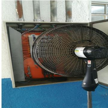
A escola tem uma instalação elétrica e hidráulica muito antiga, necessitando a revisão ou substituição para que não se exponha a riscos a comunidade escolar. A imagem de um grande ventilador direcionado a quadro elétrico da escola, pode ilustrar a situação que se encontra e a urgência de medidas para solucioná-los.
