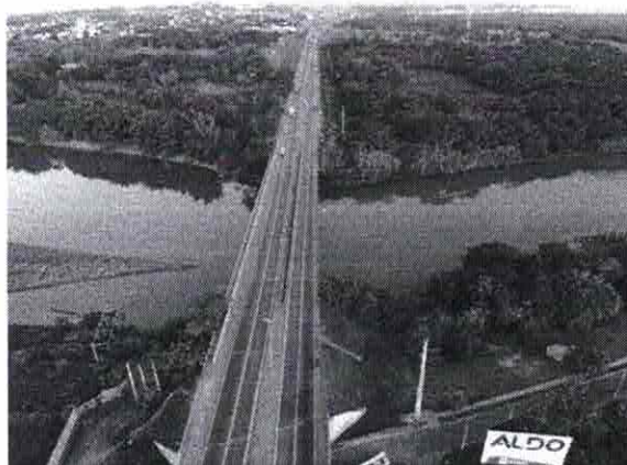
Ponte sobre o Rio Vermelho
