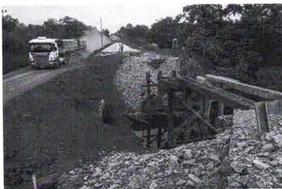
Construção da Ponte de Concreto na MT-020
