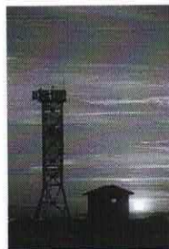
Torre de observação de aves
